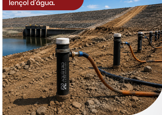
Poços Profundos Rebaixamento de lençol d'água.
